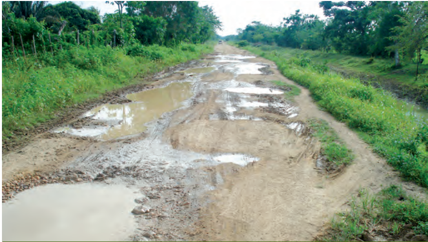
El mejoramiento de las vías en María La Baja es una prioridad en los planes de acción de la zona.
